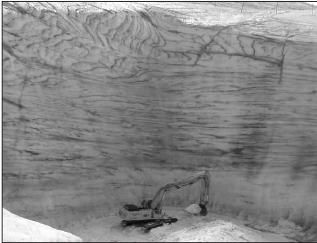
25 m tiefe Baugrube im Gletscher
