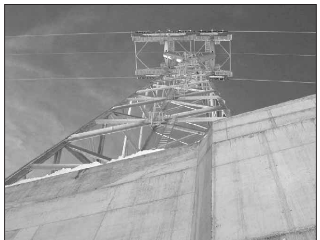
Blick von unten auf die 55 m hohe Stütze
