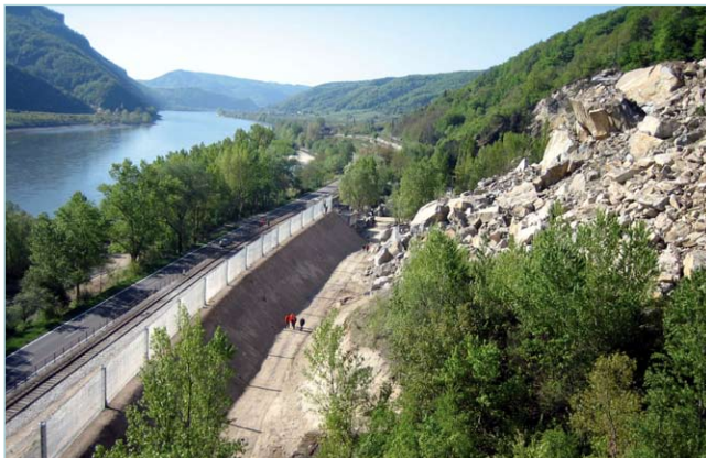
Steinbruch mit Schutzdamm, Alarmzaun, Bahn und Straße
