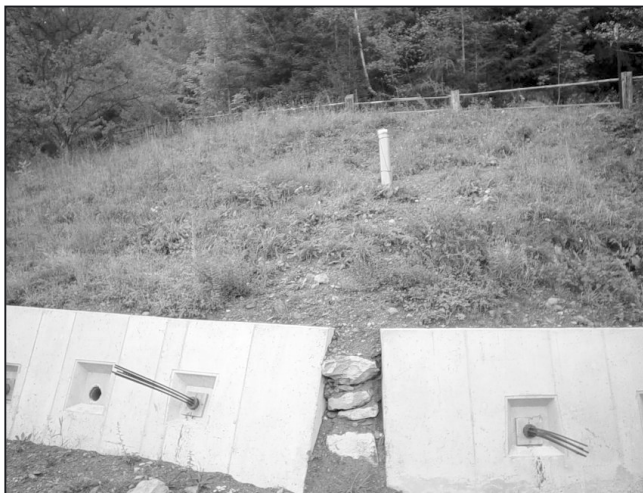
Gefährdeter Hang nach der Stabilisierung
