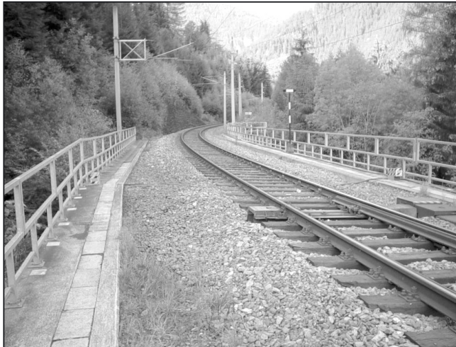
Ganderbachbrücke der ÖBB
