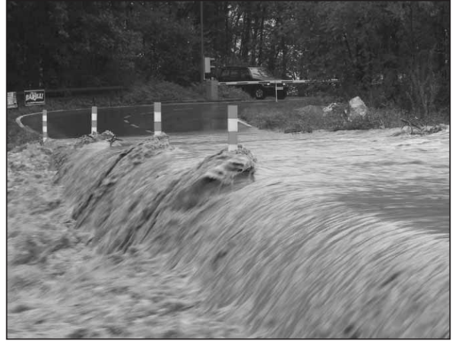
Überflutung der Furt bei Hochwasser
