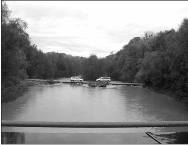
Furt vor den baulichen Maßnahmen
